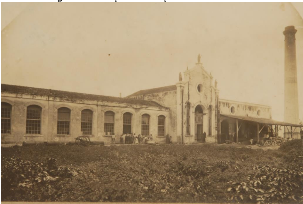
Figura 6 — Companhia de Fiação e Tecidos do Rio Anil
