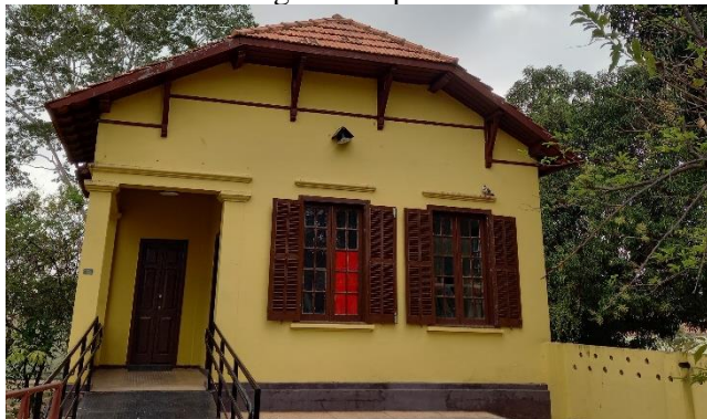
Figura 02 — Casa do Agente do pátio ferroviário de Teresina.
