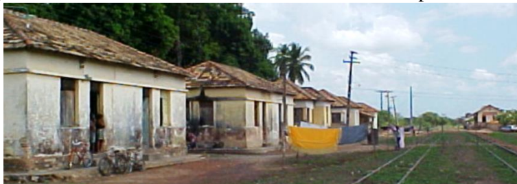
Figura 13 — Vista das casas da Vila Ferroviária de Capitão de Campos
