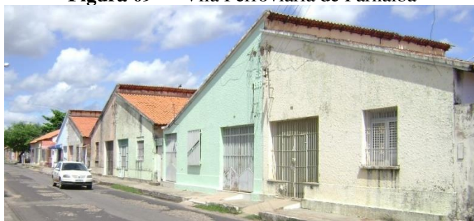
Figura 09 — Vila Ferroviária de Parnaíba
