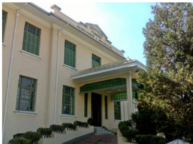
FIG. 1: AFBI FUNDADA POR ANÁLIA FRANCO. PRÉDIO TOMBADO PELO PATRIMÔNIO HISTÓRICO DA CIDADE DE SÃO PAULO.
